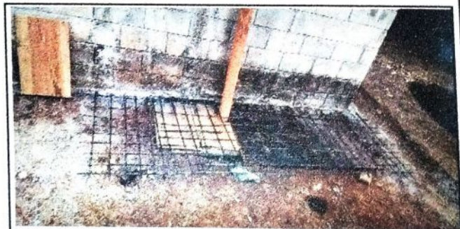
Foto 6: SUSTITUCION DE CIMIENTO PARA SANITARIO.
